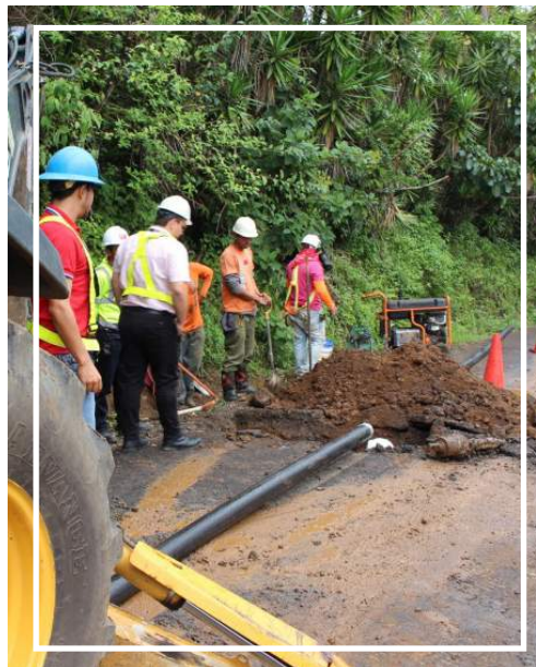
Las Tres líneas de tuberías abarcan 7.200 metros de longitud.
