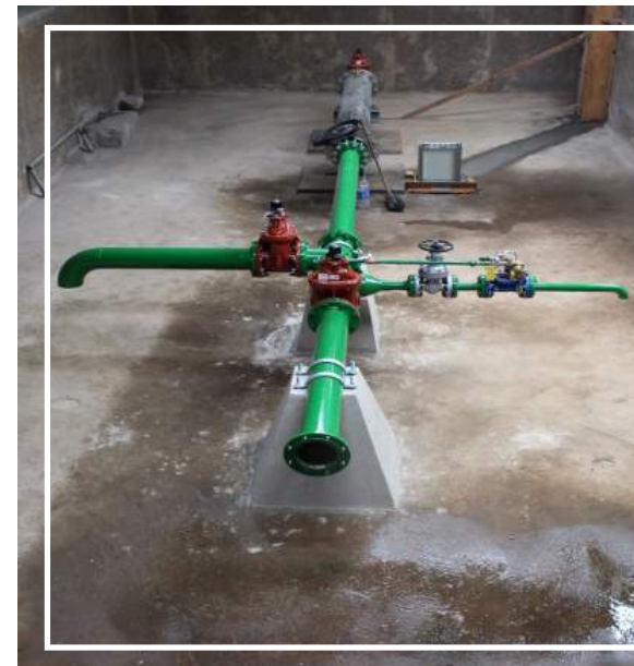
Por medio de un sistema de bombeo se unirán los tanques. Foto: ESPH
